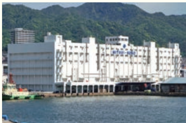
南西側から眺めた外観。屋上の中央に船の航行を確認するための展望室が載っています。角を丸めてガラスを入れた様子は船の艦橋に似ています。
