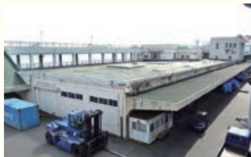
北西側から建物上部を見る。建物の塗装は変更されていますが、建物の骨格と輪郭は竣工当時の姿のまま現存しています。
