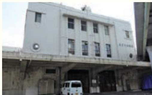
西側から建物中央部を見る。垂直線と水平線を構成し丸窓を配したアール・デコ風のデザインです。
