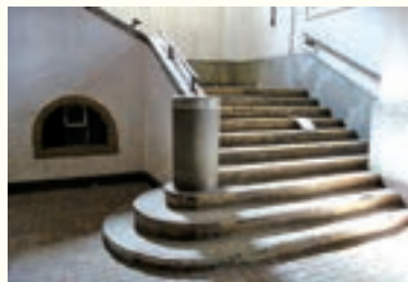
2階に上がる南側の階段。北側にも左右反転した同じ階段があります。1階の鉄道駅のプラットフォームと2階の乗船デッキを繋いでいます。
