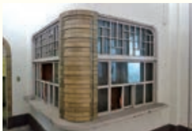
1階の受付窓口。角が丸くデザインされ、布目タイルが凹凸を付けて貼られています。窓の格子もアール・デコ風です。
