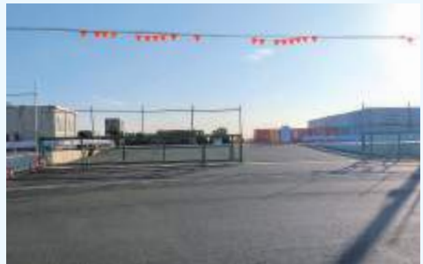
六甲アイランド嵩上げ工事の様子
