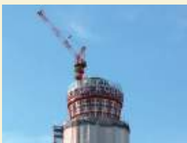
2021年9月より改修工事を開始
