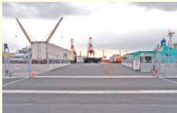
六甲アイランド高上げ工事の様子
