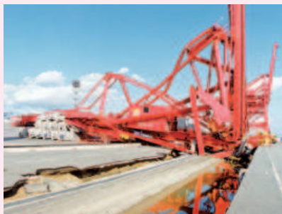
倒壊したガントリークレーン
