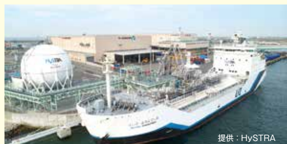
空港島における液化水素荷役の実証実験の様子
