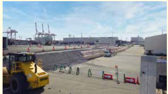
六甲アイランド嵩上げ工事の様子
