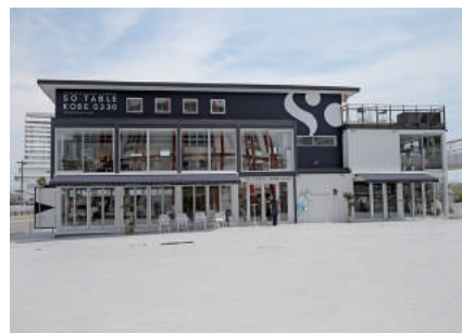
コンテナをイメージした外観
