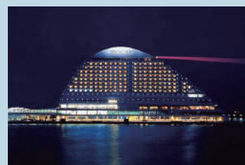
「灯光を照射する灯台」※
