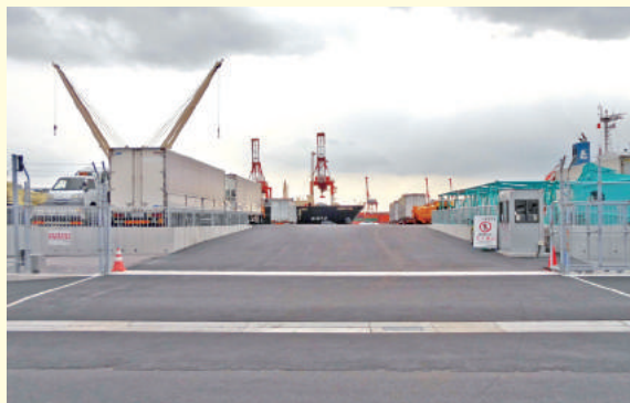
六甲アイランド高上げ工事の様子
